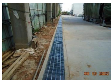
งานเทคอนกรีตและติดตั้งตะแกรงบริเวณรางระบายน้ำ
