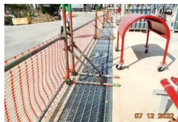
งานเทคอนกรีตและติดตั้งตะแกรงบริเวณรางระบายน้ำ รูปที่ 1-4 กิจกรรมงานก่อสร้างบริเวณพื้นที่ก่อสร้าง Area 1
