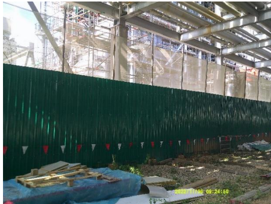
รูปที่ 2-2 แผงตาข่ายกันฝุ่นล้อมรอบพื้นที่ก่อสร้าง
