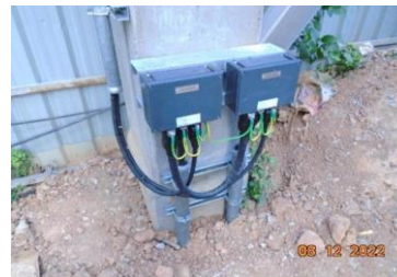
งานติดตั้งไฟส่องสว่างและกล่องรวบรวมสัญญาณ
