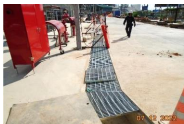
งานเทคอนกรีตและติดตั้งตะแกรงบริเวณรางระบายน้ำ รูปที่ 1-4 กิจกรรมงานก่อสร้างบริเวณพื้นที่ก่อสร้าง Area 1
