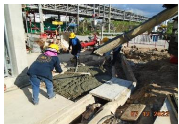
งานเทคอนกรีตและติดตั้งตะแกรงบริเวณรางระบายน้ำ
