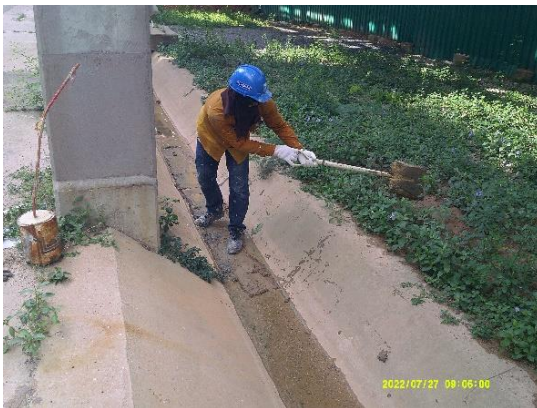
รูปที่ 2-23 การขุดลอกรางระบายน้ำ
