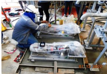
งานติดตั้ง Blow down pump
