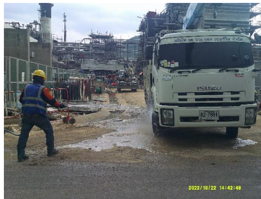
รูปที่ 2-5 การฉีดล้างล้อรถก่อนออกจากพื้นที่ก่อสร้าง
