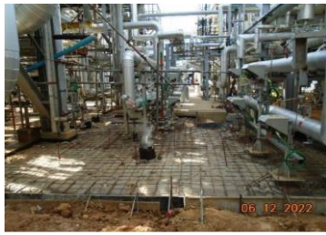
งานบดอัดดิน ผูกเหล็กเส้น และเทพื้นคอนกรีต
