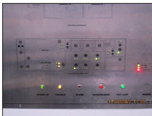
รูปที่ 3-9 แผงวงจรอิเล็กทรอนิกส์สำหรับควบคุมระบบบำบัดน้ำเสียของโครงการฯ
