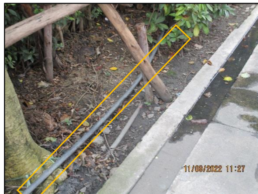
รูปที่ 2-14 การนำน้ำเสียที่ผ่านการบำบัดแล้วมาใช้รดน้ำต้นไม้ภายในพื้นที่โครงการฯ
