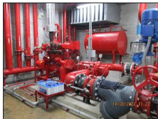
รูปที่ 2-49 เครื่องสูบน้ำดับเพลิง
