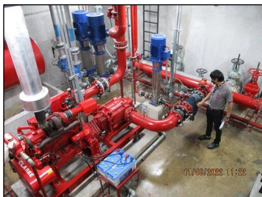
รูปที่ 2-49 เครื่องสูบน้ำดับเพลิง
