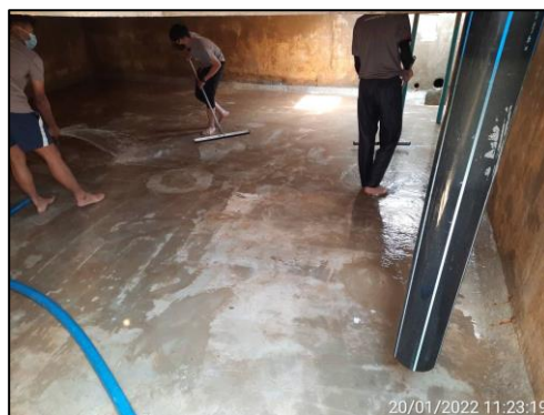
รูปที่ 3-18 การตรวจสอบและทำความสะอาดถังสำรองน้ำใช้
