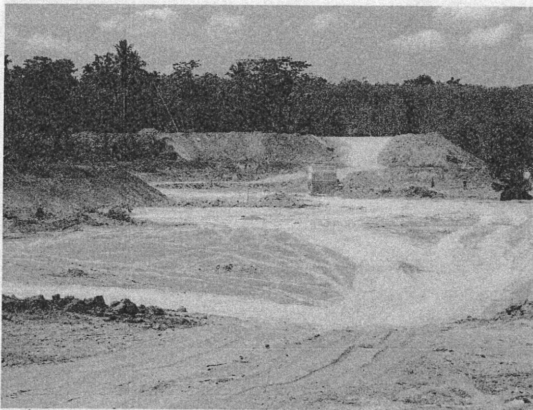
ภาพที่ 5 แสดงการปรับแต่งกองเปลือกดิน ให้มีความลาดชันที่เหมาะสม
