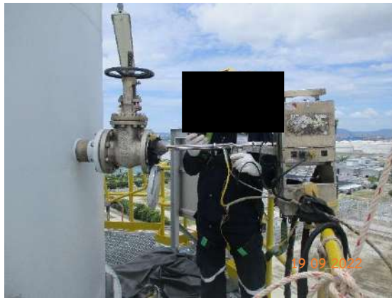
รูปที่ 3-4 การติดตามตรวจสอบคุณภาพอากาศจากแหล่งกำเนิด บริเวณปล่องระบายมลสารของโครงการ เมื่อวันที่ 19 กันยายน พ.ศ. 2565
