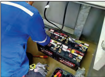
1.ติดตั้ง Temporary และ ตั้งเครื่อง E-Dummy Load เตรียมทดสอบ
