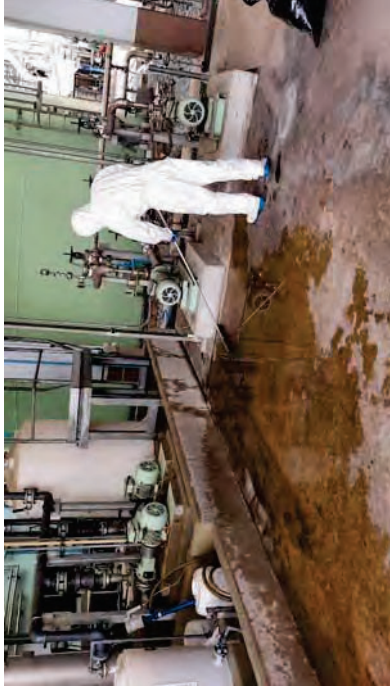
หลังจากที่พนักงานเคมีได้ทำการตรวจวัดค่า Ph แล้วและตรวจวัดเป็นที่แน่ใจว่าไม่มีสารเคมีปนเปื้อน จึงใช้วิธีตกคาน้ำลงสู่รางระบายน้ำ
