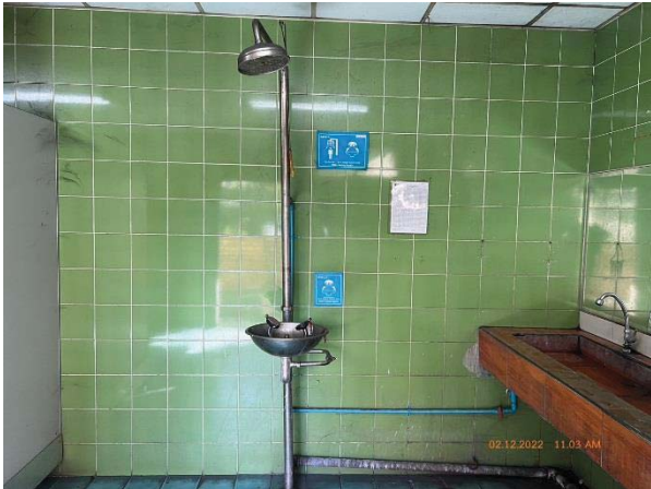
ภาพที่ 37 ฝักบัวและอ่างล้างตาฉุกเฉิน
