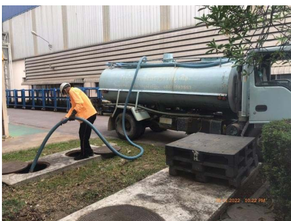
ภาพที่ 21 การดูแลทำความสะอาดถังบำบัดน้ำเสียสำเร็จรูป
