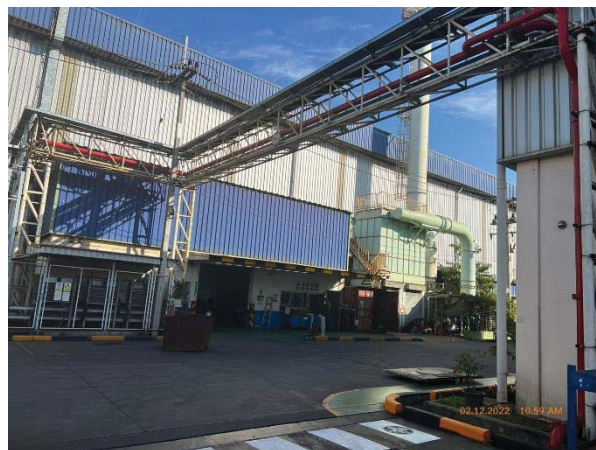
ภาพที่ 48 ระบบท่อน้ำดับเพลิง
