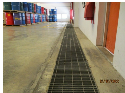
รูปที่ 3-54 รางระบายน้ำในอาคารเก็บของเสีย
