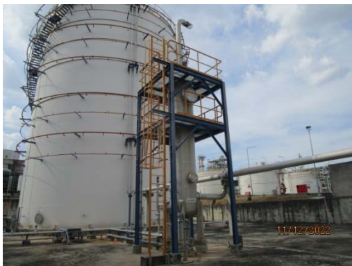
รูปที่ 3-11 ระบบดักจับไอระเหยด้วยน้ำ (Acetone Wet Scrubber) ของถังเก็บสารอะซิโตน (TK-4163A/B)
