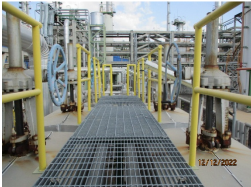
รูปที่ 3-68 ระบบท่อเชื่อมสำหรับขนถ่าย ไนโตรเจน
