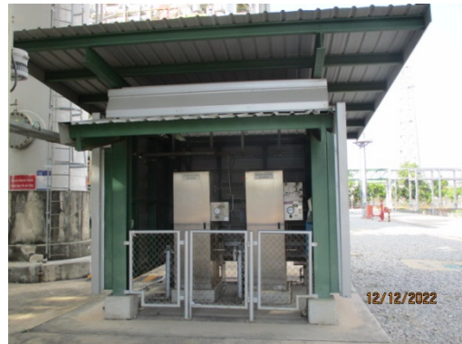
รูปที่ 3-6 เครื่องตรวจวัดเบนซินแบบต่อเนื่อง ที่ปล่อง Charcoal Adsorber 2
