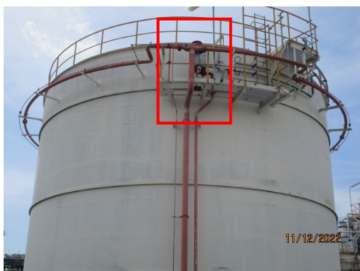
รูปที่ 3-66 ระบบโฟมของถังเก็บกักสารเคมี
