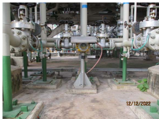
รูปที่ 3-14 Gas Detector
