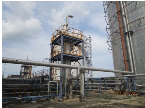
รูปที่ 3-10 ระบบดักจับไอระเหยด้วยน้ำ (Phenol Wet Scrubber) ของถังเก็บสารฟีนอล (TK-4162A/B)
