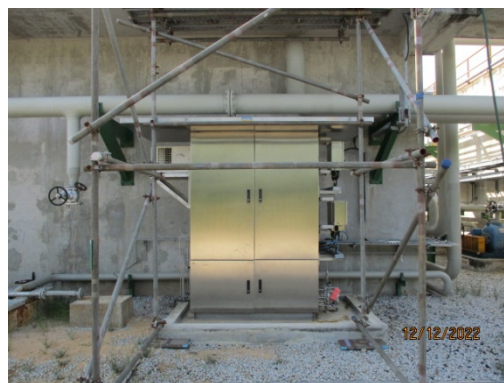
รูปที่ 3-32 เครื่องตรวจวัด COD แบบอัตโนมัติ ที่ Final Polishing Buffer Tank (TK-9145)
