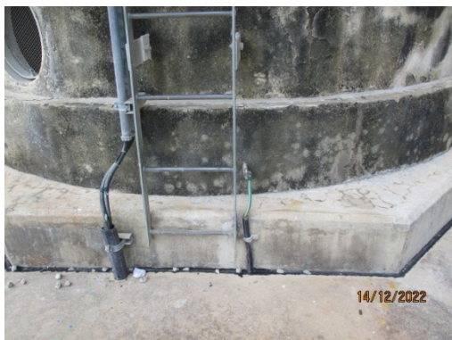
รูปที่ 3-62 ระบบสายดินที่ถังเก็บก๊าซสารเคมี
