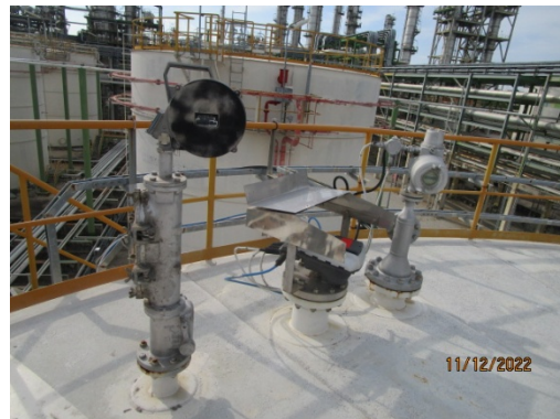
รูปที่ 3-71 Pressure/Vacuum Vent Valve
