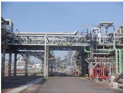
รูปที่ 2-39 การวางท่อน Pipe Rack หรือ Pipe Bridge ในลักษณะที่ปลอดภัย
