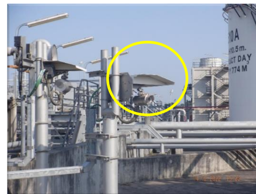
รูปที่ 2-30 ระบบตรวจจับก๊าซพิษในพื้นที่กระบวนการผลิต
