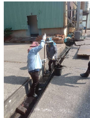
ภาพที่ 2.2-39 การขุดลอกรางระบายน้ำ
