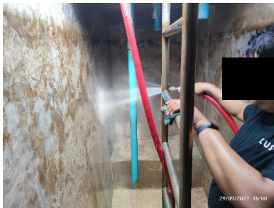
ภาพที่ 2.2-14 (ต่อ) การดูแลรักษาถังเก็บน้ำ และการทำความสะอาด
