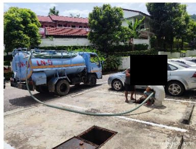
ภาพที่ 2.2-12 (ต่อ) การสูบกากตะกอน ตักตะกอน ไขมัน
