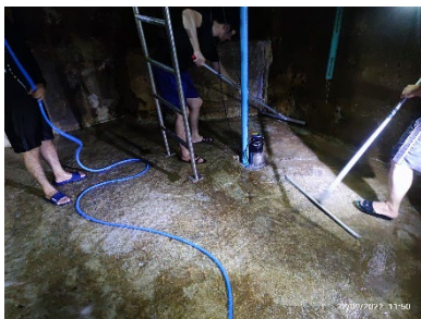
ภาพที่ 2.2-14 การดูแลรักษาถังเก็บน้ำ และการทำความสะอาด
