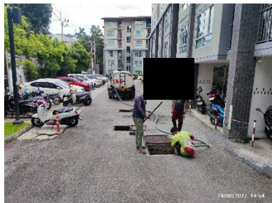
ภาพที่ 2.2-12 (ต่อ) การสูบกากตะกอน ตักตะกอน ไขมัน
