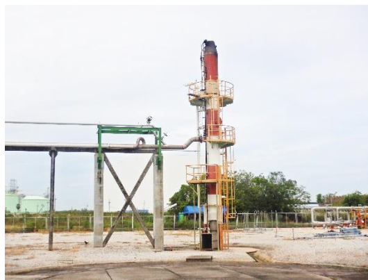
รูปที่ 2.1-1 หอเผาแบบปิด (Enclosed Ground Flare)
