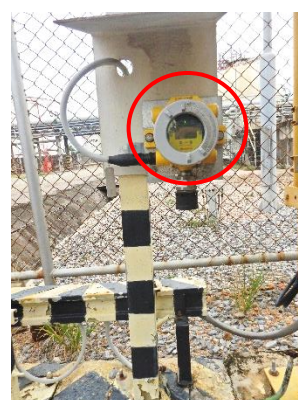
รูปที่ 2.1-3 ติดตั้งเครื่องตรวจจับก๊าซ (Gas Detector) บริเวณสถานีสูบน้ำทางรถบรรทุก
