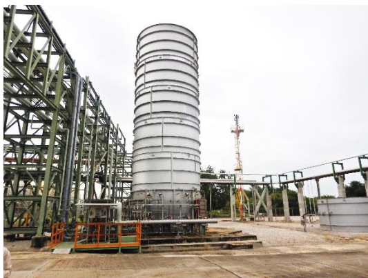
รูปที่ 2.1-1 หอเผาแบบปิด (Enclosed Ground Flare)
