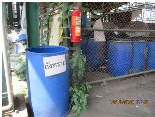
รูปที่ 62 ถังทรายขนาด 200 ลิตร สำหรับกอบกู้สารเคมีรั่วไหล
