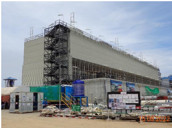
รูปที่ 1-4 งานหอหล่อเย็น (Cooling Tower)
