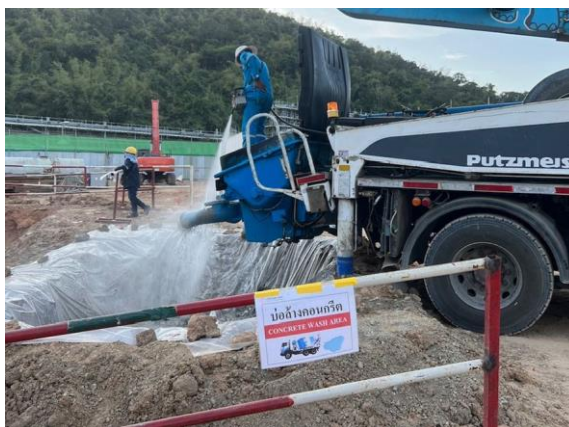
รูปที่ 2-9 การทำความสะอาดรางระบายคอนกรีตของรถขนคอนกรีต
