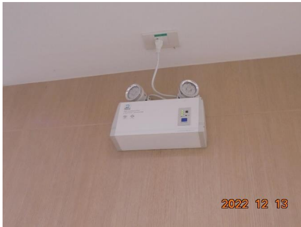
รูปที่ 2-34 ติดตั้งเครื่องสำรองไฟฟ้าใช้กรณีฉุกเฉิน
