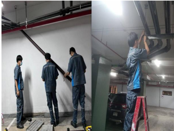
รูปที่ 2-10 เจ้าหน้าที่ดูแลรักษาระบบเส้นท่อประปา การรั่วไหลของน้ำ
