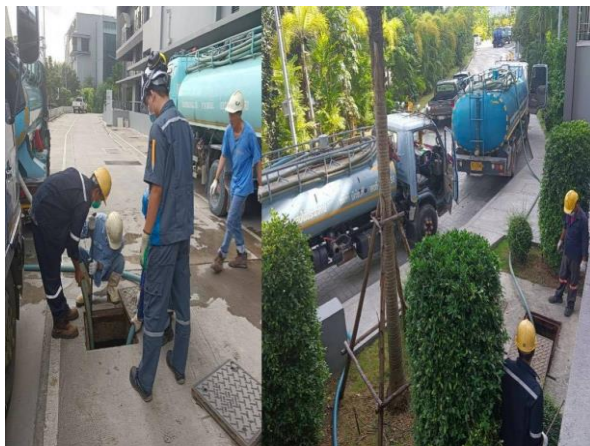
รูปที่ 2-15 ประสานงานกับรถสูบล้างถังของเอกชน เพื่อสูบน้ำมันของระบบบำบัดน้ำเสียไปกำจัดต่อไป
