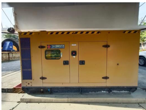
รูปที่ 9 ระบบไฟฟ้าสำรองของระบบบำบัดน้ำเสียส่วนกลางของนิคมฯ
