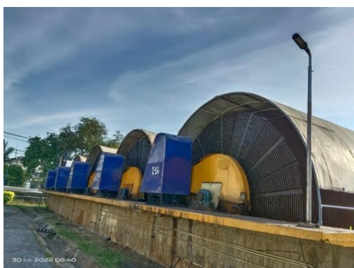
ระบบบำบัดน้ำเสียแห่งที่ 2 ชนิด Rotating Biological Contractor (RBC)
