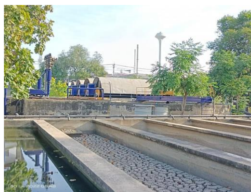
ระบบบำบัดน้ำเสียแห่งที่ 2 ชนิด Rotating Biological Contractor (RBC)
