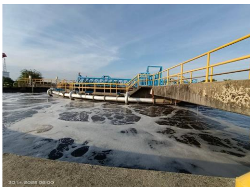
ระบบบำบัดน้ำเสียแห่งที่ 1 ชนิด Aerated Lagoon & Activated Sludge
