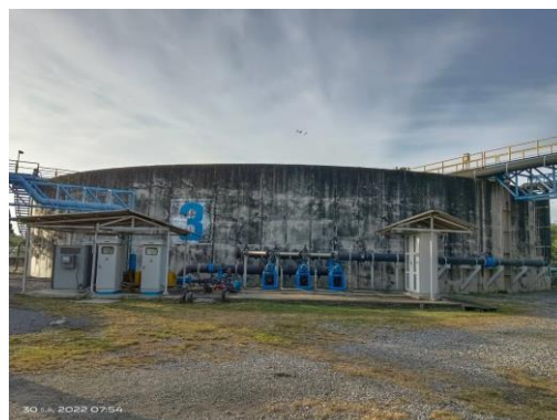
ระบบบำบัดน้ำเสียแห่งที่ 1 ชนิด Aerated Lagoon & Activated Sludge
