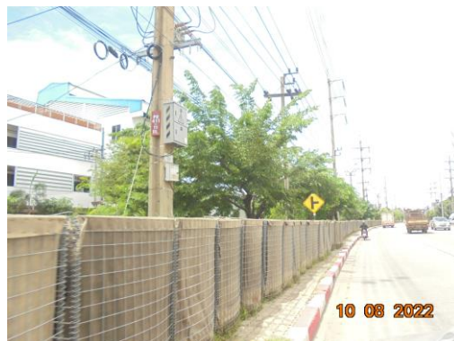
รูปที่ 22 กำแพง Big Bag สำหรับเป็นแนวป้องกันน้ำท่วม
