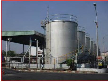
ภาพที่ 2.2-11 แทงค์รองรับน้ำปนเปื้อนสำรอง
