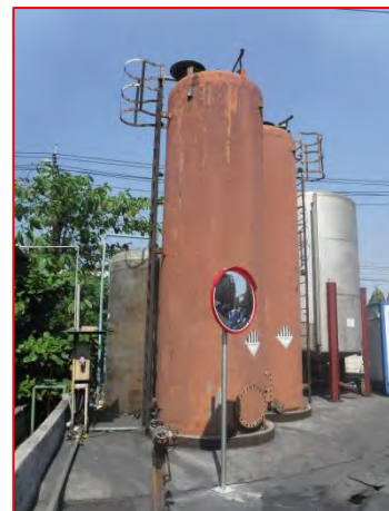
ภาพที่ 2.2-10 บ่อ Sump หรือบ่อพักน้ำปนเปื้อนที่ติดตั้งเครื่องสูบน้ำยังเตาเผาขยะ
