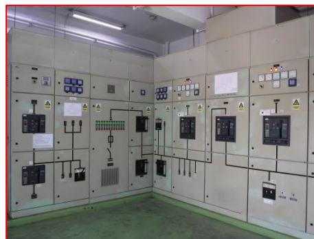
ภาพที่ 2.2-3 ระบบไฟฟ้าสำรองสำหรับ เตาเผา ส่วนที่ 1
