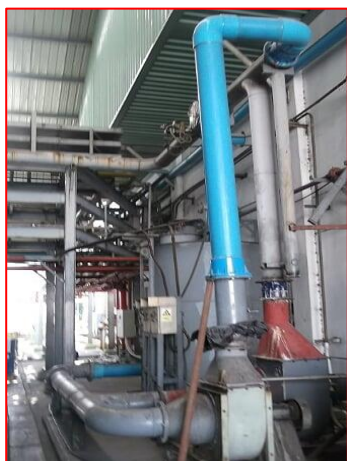
ภาพที่ 2.2-4 ระบบระบายอากาศ, ระบบบำบัดกลิ่นภายในห้องสูบล้างของเสีย ที่เป็นของเหลว และระบบบำบัดอากาศ กรณีเตาเผาเกิดขัดข้อง
