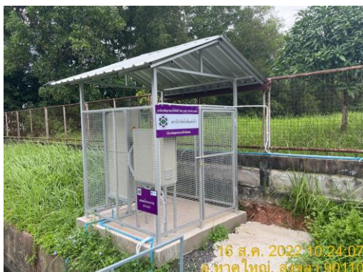
รูปที่ 5 เครื่องวัดอัตราการไหลของน้ำทิ้งและเครื่องวัดค่า COD ที่จุดปล่อยน้ำทิ้งจากบ่อพัก
