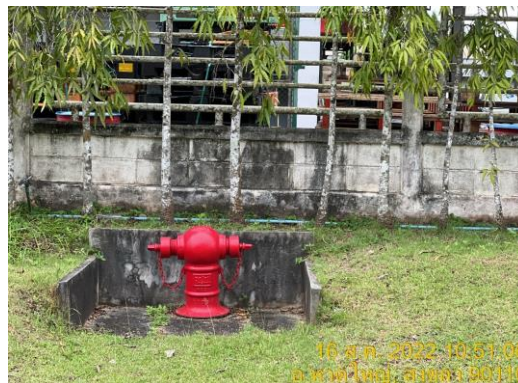
รูปที่ 20 อุปกรณ์ดับเพลิงในพื้นที่โครงการ ทุกๆ 200 เมตร
