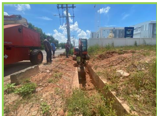
รูปที่ 2 การขุดลอกท่อระบายน้ำเสียและวางระบายน้ำผิวดินและบ่อฝัง
