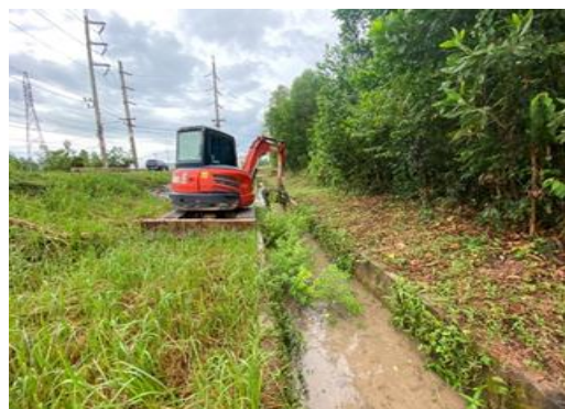
รูปที่ 2 การขุดลอกท่อระบายน้ำเสียและวางระบายน้ำผิวดินและบ่อฝัง
