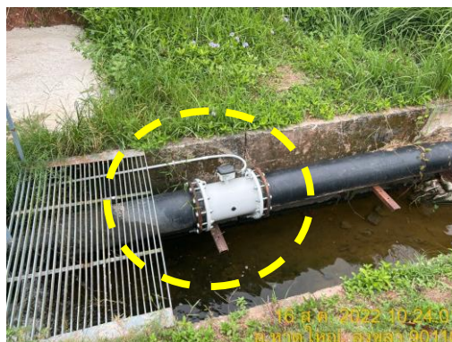
รูปที่ 5 เครื่องวัดอัตราการไหลของน้ำทิ้งและเครื่องวัดค่า COD ที่จุดปล่อยน้ำทิ้งจากบ่อพัก
