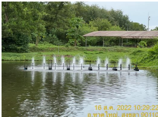
รูปที่ 4 บ่อพักน้ำทิ้ง ขนาด 3,000 ลบ.ม.พร้อมเครื่องเติมอากาศ
