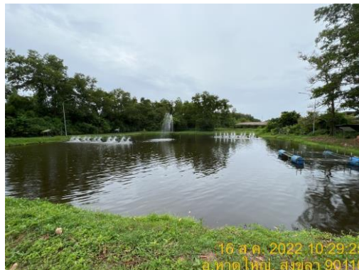
รูปที่ 4 บ่อพักน้ำทิ้ง ขนาด 3,000 ลบ.ม.พร้อมเครื่องเติมอากาศ
