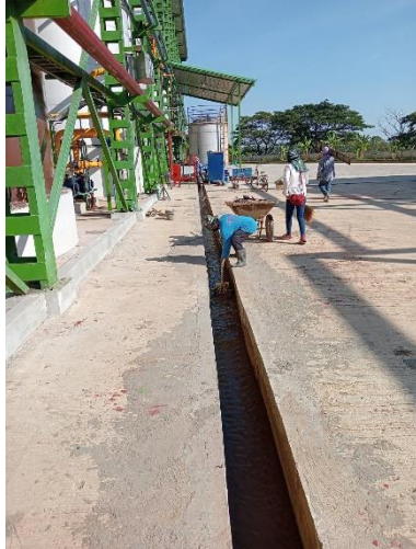
รูปที่ 14 (ต่อ) การขุดลอกและการทำความสะอาดรางระบายน้ำ
