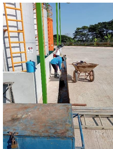
รูปที่ 14 การขุดลอกและการทำความสะอาดรางระบายน้ำ
