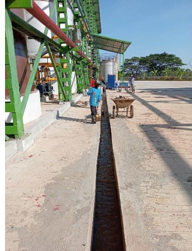
รูปที่ 14 (ต่อ) การขุดลอกและการทำความสะอาดรางระบายน้ำ
