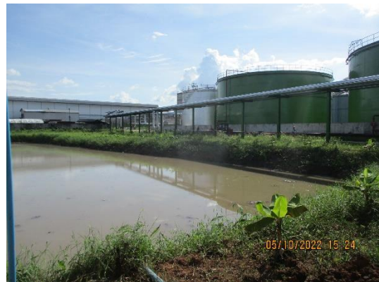
รูปที่ 7 บ่อเกรอะ-กรองไร้อากาศและเติมอากาศ
