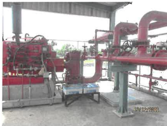
ปั้มน้ำดับเพลิง (Fire Pump)
