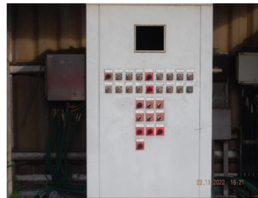
รูปที่ 2-32 ระบบหยุดสุบถ่ายฉุกเฉินทั้งระบบ บริเวณถังจัดเก็บ
