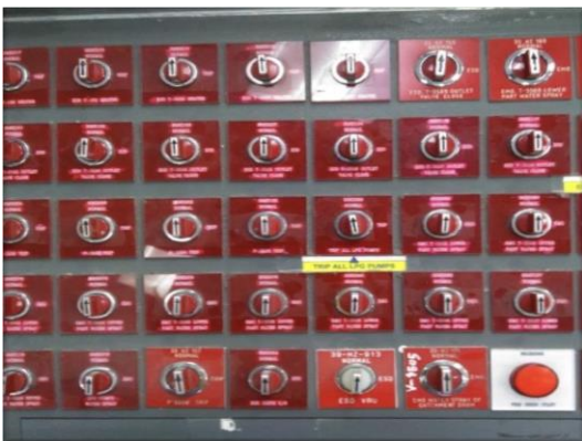
รูปที่ 2-33 ระบบหยุดสุบถ่ายฉุกเฉินทั้งระบบ บริเวณห้องควบคุม
