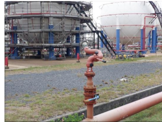
รูปที่ 2-40 หัวฉีดน้ำและโคมดับเพลิงระยะไกล
