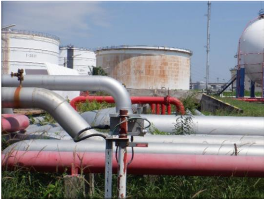
รูปที่ 2-23 อุปกรณ์ตรวจสอบสารไวไฟรั่วไหลแบบลำแสง
