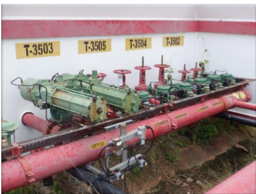
รูปที่ 2-37 วาล์วน้ำหล่อเย็นแบบเปิดอัตโนมัติเมื่อไฟไหม้ (Deluge valve system)
