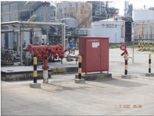
รูปที่ 2-41 หัวฉีดน้ำดับเพลิงชนิดประจำพื้นที่ (Deluge valve system)
