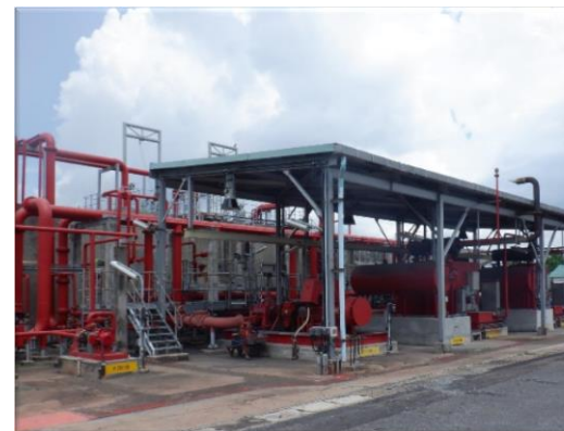
รูปที่ 2-44 บั๊มน้ำดับเพลิง
