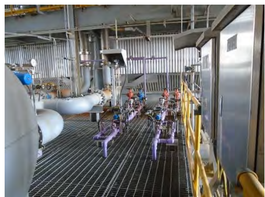
ภาพที่ 2-17 อุปกรณ์ควบคุมออกไซด์ของไนโตรเจน (SCR)
