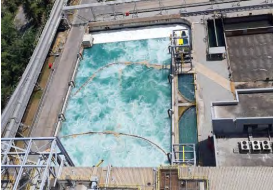
ภาพที่ 2-43 บ่อเติมอากาศ (Aeration Basin)
