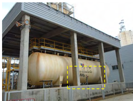
ภาพที่ 2-82 อุปกรณ์ตรวจวัดแอมโมเนีย บริเวณถังเก็บกัก
