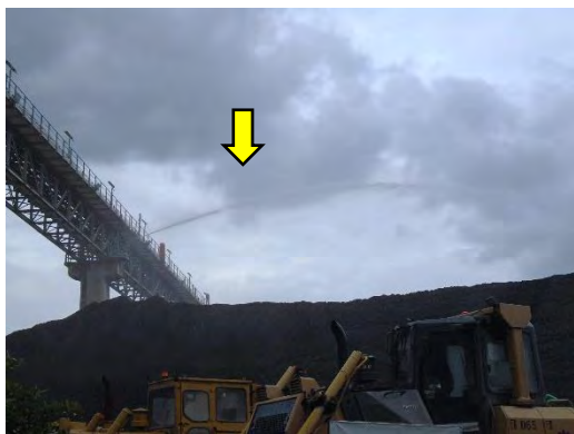
ภาพที่ 2-9 การฉีดพ่นน้ำบริเวณสายพานโปรยถ่านหิน ลงสู่กองถ่านหิน
