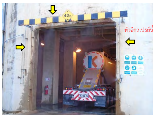
ภาพที่ 2-28 การล้างทำความสะอาดรถบรรทุกเถ้าถ่านหิน หลังการขนถ่าย
