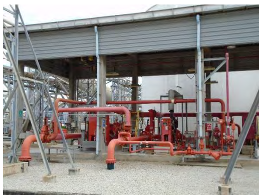
ภาพที่ 2-81 ระบบสูบน้ำดับเพลิง
