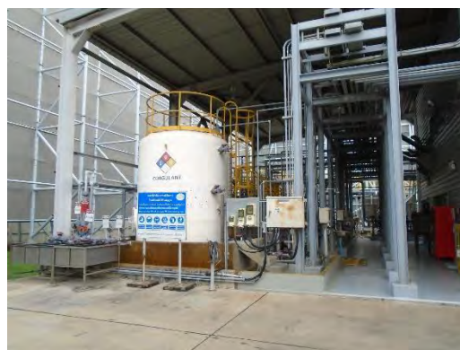
ภาพที่ 2-40 ระบบบำบัดน้ำเสียแบบเคมี
