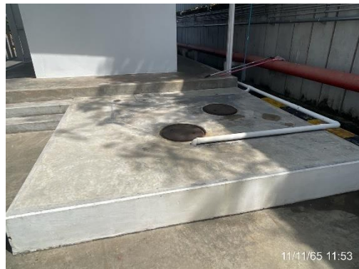
รูปที่ 36 ระบบบำบัดน้ำเสียสำเร็จรูป
