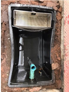
รูปที่ 37 บ่อดักจับคราบน้ำมันและน้ำมัน (Oil Separator)
