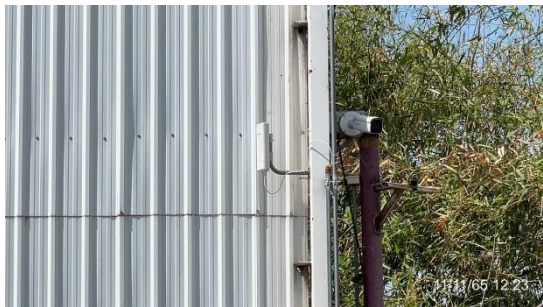
รูปที่ 30 การติดตั้งกล้องวงจรปิด (CCTV)
