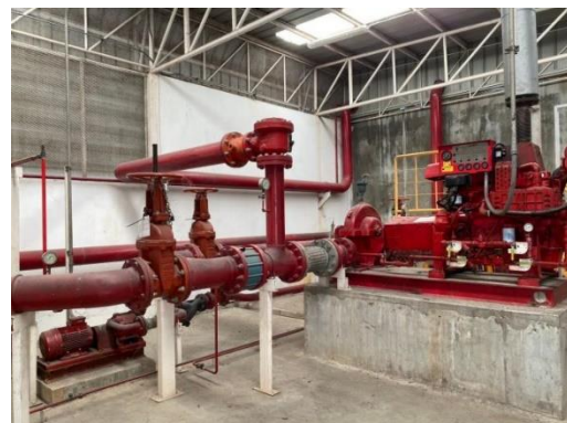
รูปที่ 45 เครื่องสูบน้ำดับเพลิง (Fire Pump)
