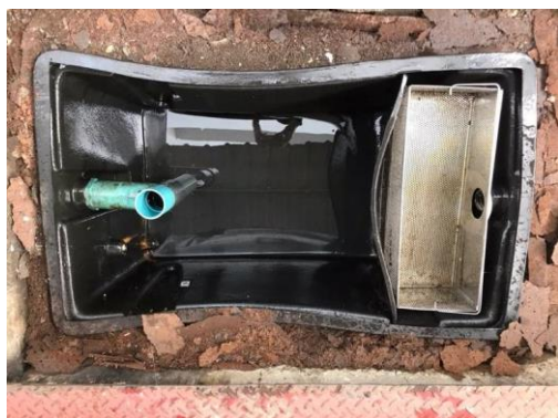
รูปที่ 35 ถังดักไขมัน (Grease Trap)
