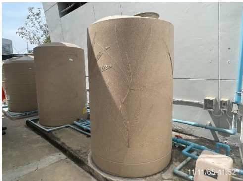
รูปที่ 32 ถังเก็บน้ำขนิดวางบนดิน
