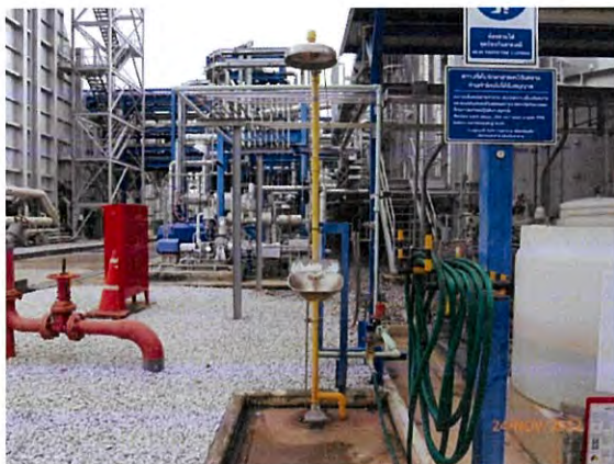
ภาพที่ 2.2-32 อุปกรณ์ชำระล้างฉุกเฉิน (Emergency Shower and Eye Wash Fountain)
