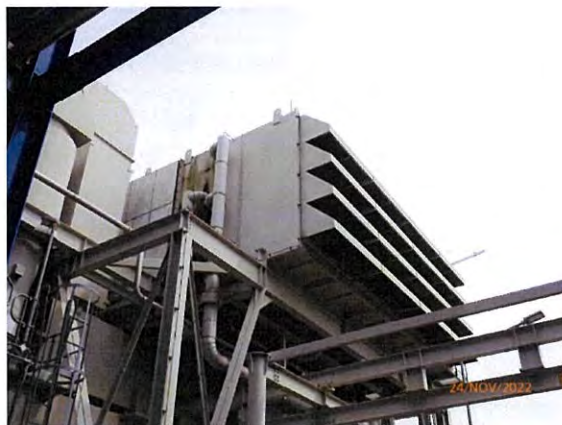
ภาพที่ 2.2-5 Silencer ทางออกไอเสียของเครื่องกังหันก๊าซ
