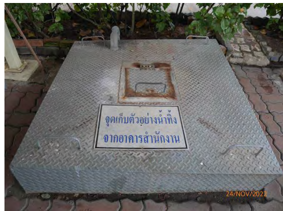
ภาพที่ 2.2-19 บ่อตรวจสอบคุณภาพน้ำทิ้งจากอาคาร สำนักงาน
