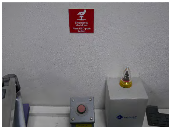
ภาพที่ 2.2-56 ปุ่ม Emergency shutdown
