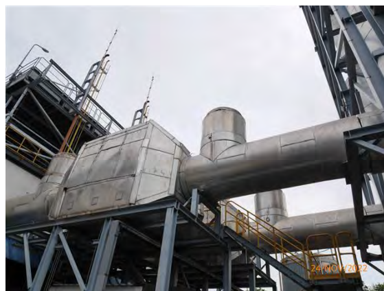
ภาพที่ 2.2-7 selective catalytic reduction; SCR
