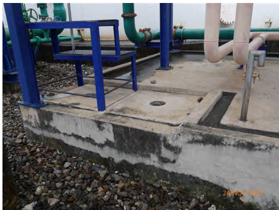
ภาพที่ 2.2-18 ถังแยกน้ำ-น้ำมัน (Oil Separator)
