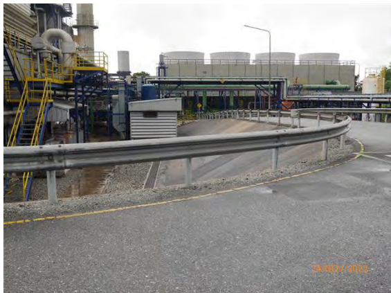
ภาพที่ 2.2-28 แนว Barrier กันเพื่อป้องกัน รถหลุดออกนอกเส้นทาง
