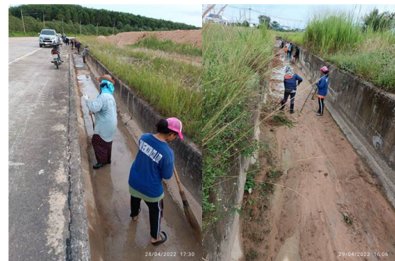
ภาพที่ 2-12 การกำจัดวัชพืชและทำความสะอาดรางระบายน้ำฝนภายในพื้นที่โครงการ
