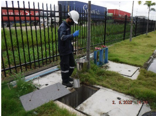
ภาพที่ 2-1 บ่อตรวจสอบสภาพน้ำ (Inspection Manhole)
