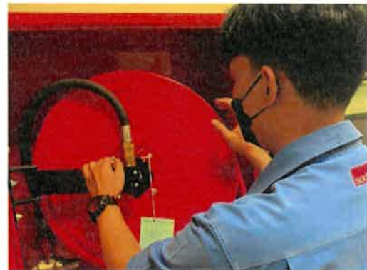
ทดสอบสายยางดับเพลิง ในตู้ FHC
