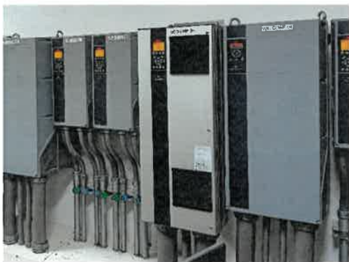
อุปกรณ์ควบคุมความเร็วรอบมอเตอร์ (Variable Speed Drive : VSD) เพื่อช่วยประหยัดพลังงาน
