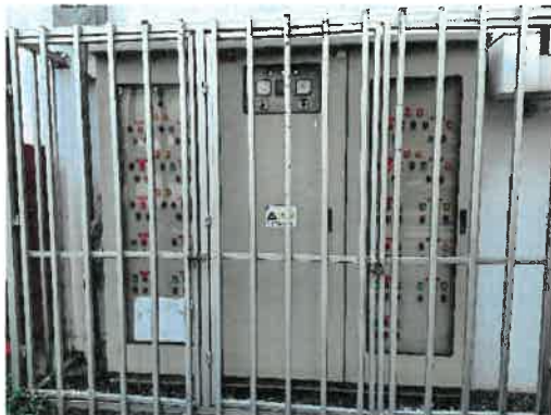
ตู้ควบคุมระบบบำบัดน้ำเสียและมิเตอร์ระบบบำบัด
