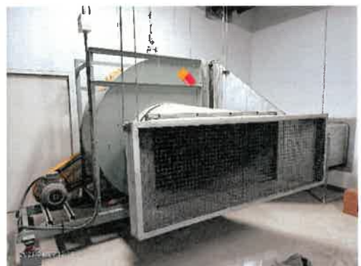
พัดลมระบายอากาศที่จ่อตรงชั้นใต้ดิน
