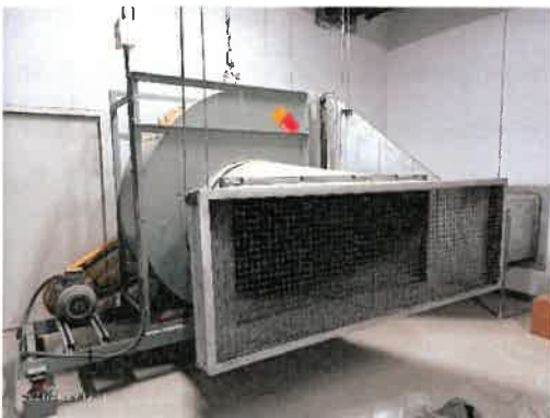
พัดลมระบายอากาศที่จอดรถชั้นใต้ดิน
