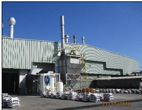
รูปที่ 2-3 Dust Collector
