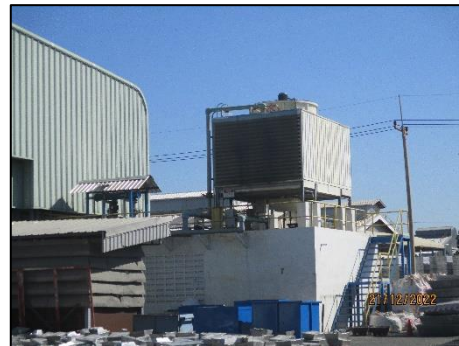
รูปที่ 2-13 Cooling Tower
