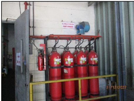
รูปที่ 2-41 ระบบ CO 2 ดับเพลิงอัตโนมัติ
