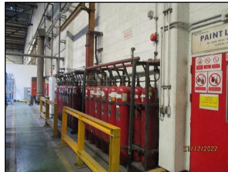
รูปที่ 2-41 ระบบ CO 2 ดับเพลิงอัตโนมัติ
