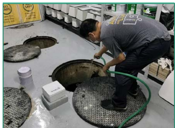
รูปที่ 2-11 การสูบล้างตะกอน และดักกากไขมัน
