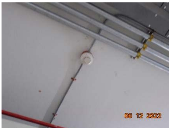
รูปที่ 2-42 เครื่องตรวจจับควัน (Smoke Detector) ภายในห้องหม้อแปลงไฟฟ้า
