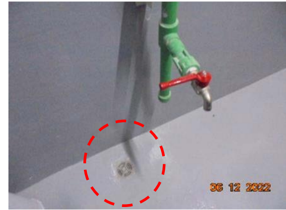
รูปที่ 2-32 ท่อรวบรวมน้ำเสียในห้องพักมูลฝอยรวม
