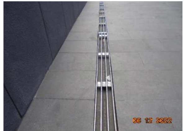
รูปที่ 2-69 ตะแกรงครอบท่อระบายน้ำ
