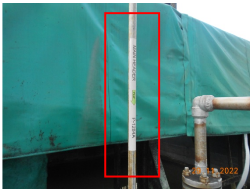
รูปที่ 15 ระบบท่อ Minimum Flow Line
