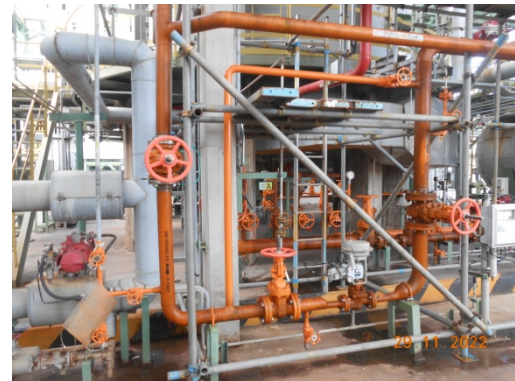
รูปที่ 46 วาล์วตัดแยกระบบท่อขนส่ง ก๊าซธรรมชาติ
