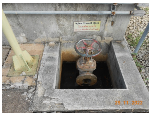
รูปที่ 42 Block Valve
