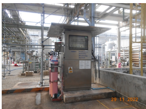
รูปที่ 3 Continuous Emission Monitoring System, CEMS
