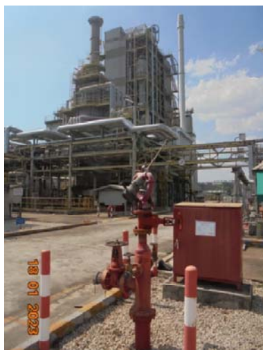
รูปที่ 50 Fire Hydrant บริเวณท่อขนส่งก๊าซธรรมชาติ
