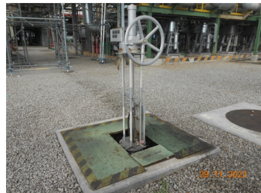
รูปที่ 16 วาล์วตัดแยกระบบบำบัดน้ำเสีย
