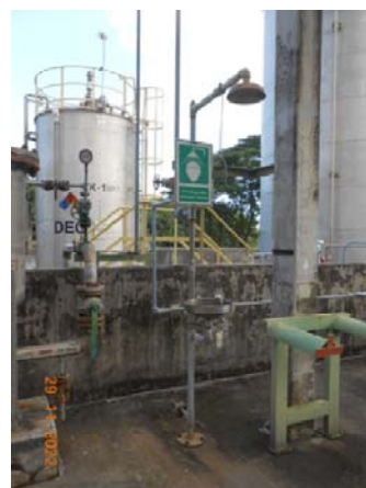
รูปที่ 30 ฝักบัวและอ่างล้างตาฉุกเฉิน
