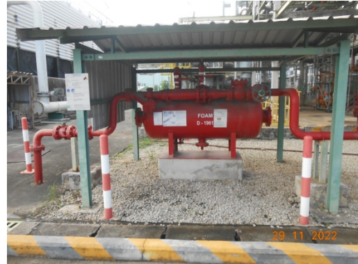
รูปที่ 32 ระบบโฟมดับเพลิง
