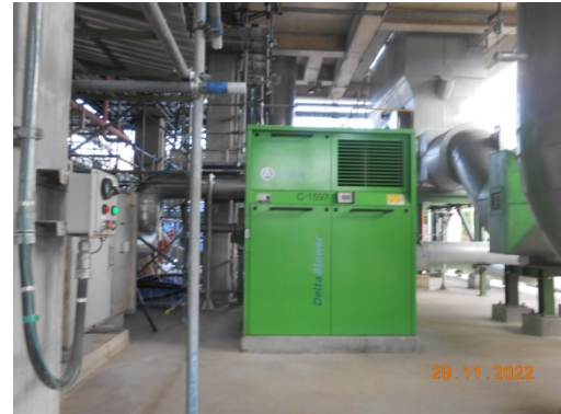
รูปที่ 20 ที่ครอบเครื่องจักรป้องกันเสียง
