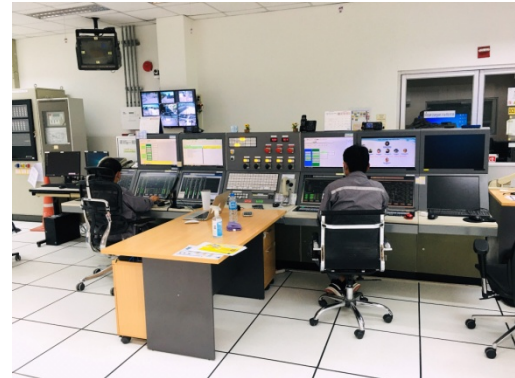
รูปที่ 44 Distributed Control System (DCS)
