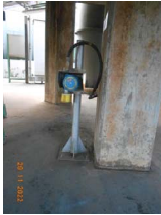
รูปที่ 31 Gas Detector
