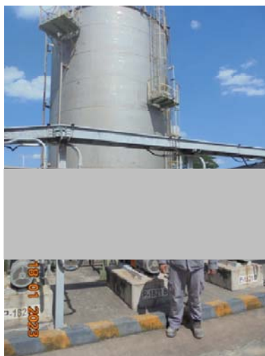
รูปที่ 49 เจ้าหน้าที่เดินตรวจสอบการรั่วไหลและเหตุการณ์ผิดปกติรอบถังเก็บ และแนวท่อขนส่งโมโนเอทรีลีนไกลคอล
