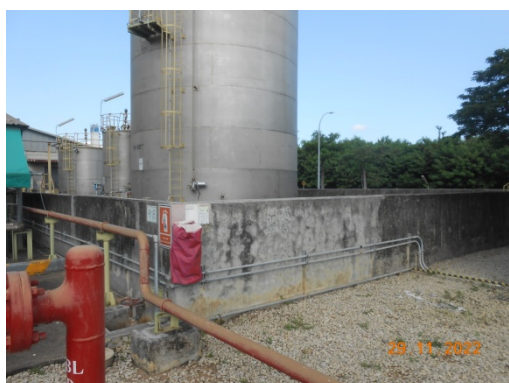
รูปที่ 41 คันคอนกรีตรอบพื้นที่เก็บสารเคมี
