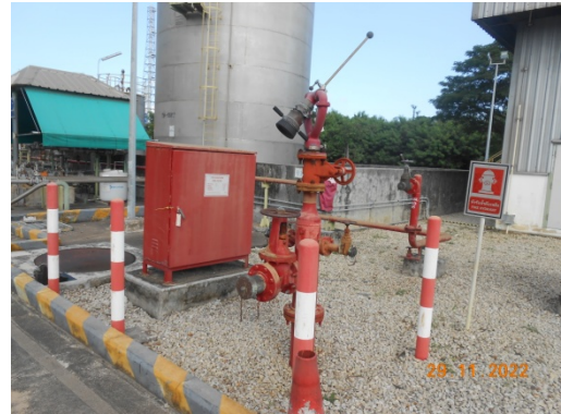
รูปที่ 34 Fire Hydrant
