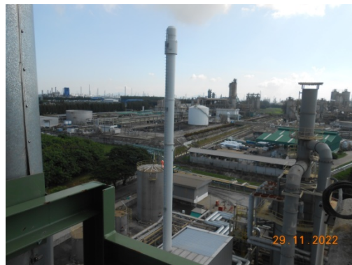
รูปที่ 2 ปล่องระบายอากาศ HTM Heater ชุดที่ 2 (F-1901-2)
