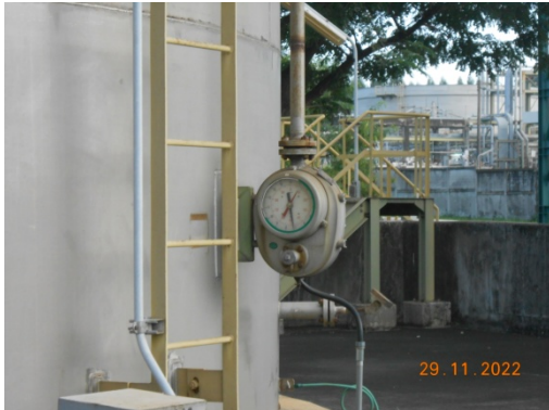
รูปที่ 43 อุปกรณ์วัดระดับสารเคมี (Level Indicator, Level Gauge)
