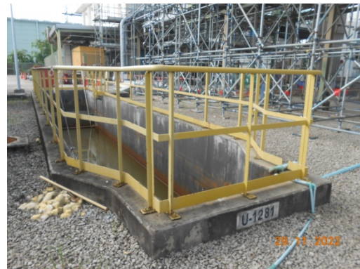
รูปที่ 10 Oil Separator
