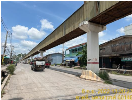
รูปที่ 5 สายพานลำเลียงที่ผ่านชุมชนมีฝาท่อปิดมิดชิด
