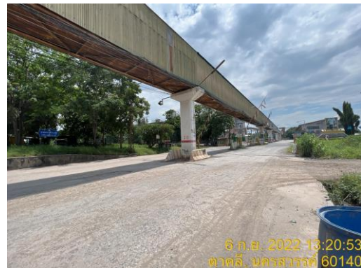
รูปที่ 5 สายพานลำเลียงที่ผ่านชุมชนมีฝาท่อปิดมิดชิด
