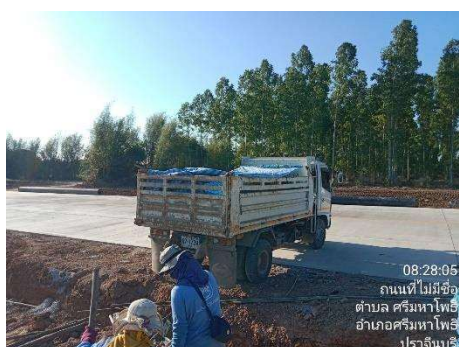
รูปที่ 2-7 การปิดคลุมรถขนส่งวัสดุก่อสร้าง
