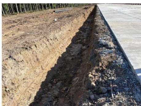
รูปที่ 2-5 รางระบายน้ำฝนในพื้นที่ก่อสร้าง
