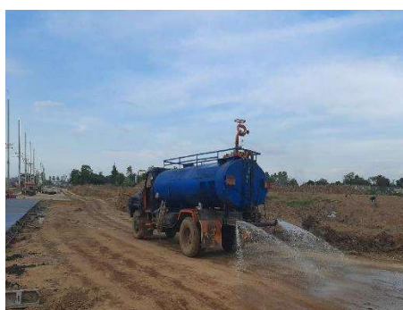
รูปที่ 2-6 การฉีดพรมน้ำบริเวณทางเข้าพื้นที่ก่อสร้าง
