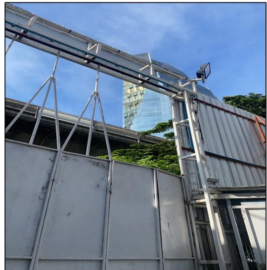
รูปที่ 6 การฉีดพรมน้ำเพื่อลดฝุ่น
