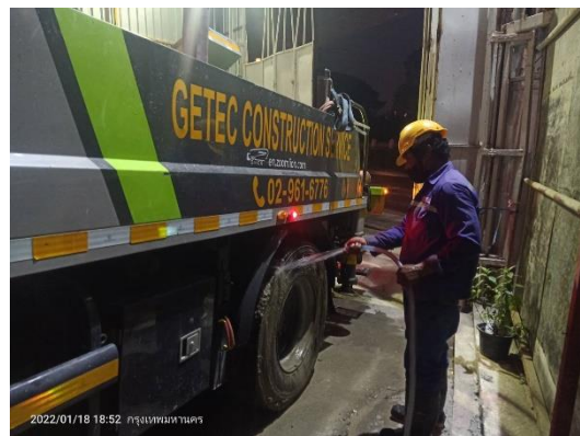
รูปที่ 13 การล้างทำความสะอาดล้อรถบรรทุก
