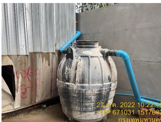
รูปที่ 20 ถังบำบัดน้ำเสียสำเร็จรูป
