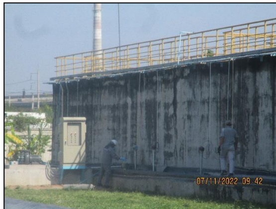
รูปที่ 4.30 การเก็บตัวอย่างน้ำทิ้งจากระบบบำบัดน้ำเสียแห่งที่ 4 (Sequencing Batch Reactor) บริเวณ Effluent
