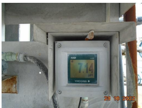
ภาพที่ 2.1-9 เครื่องตรวจวัดคุณภาพน้ำเสียแบบต่อเนื่อง ได้แก่ pH และ Temperature (น้ำที่ผ่านการบำบัดจาก API Separator Unit)
