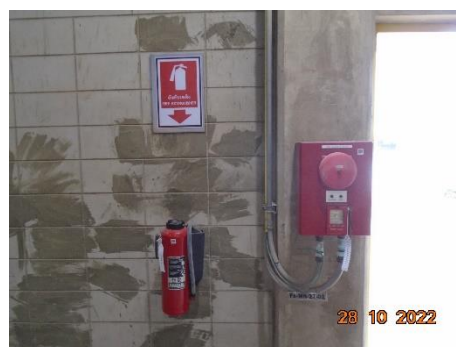
ภาพที่ 2.1-30 ระบบสัญญาณเตือน (Historian Alarm) และระฆังเครื่องไฟฟ้า
