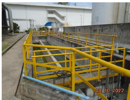
ภาพที่ 2.1-8 ระบบแยกน้ำมัน API Separator Unit
