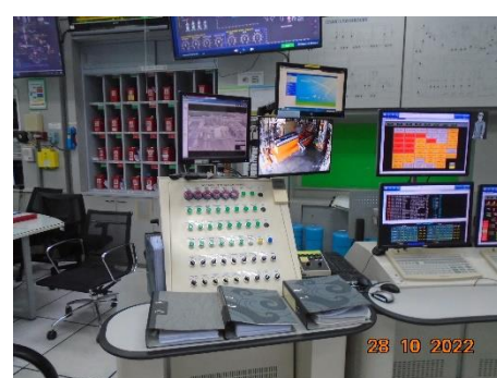
ภาพที่ 2.1-29 Interlock System และ Alarm Annunciator
