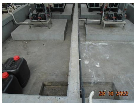
ภาพที่ 2.1-37 รางระบายบริเวณสถานที่เก็บสารเคมี
