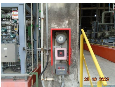
ภาพที่ 2.1-30 ระบบสัญญาณเตือน (Historian Alarm) และระฆังเครื่องไฟฟ้า
