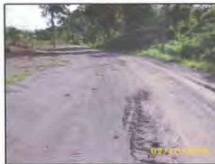
เส้นทางจากเหมืองถึงโรงโม่หิน เป็นหินปูนบดอัดแน่นโดยตลอด
