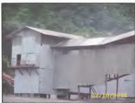
การปิดคลุมโรงไม้หินเป็นระบบปิดทั้ง 3 ด้าน
