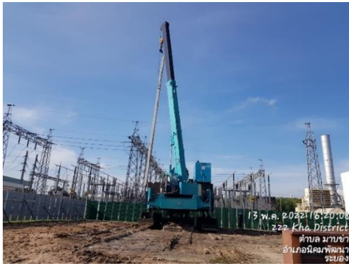
(14) เครื่องยกเสาเข็มระบบไฮดรอลิก
