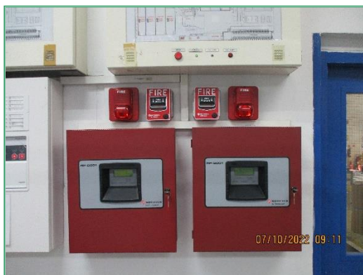
ภาพที่ 2.18 สัญญาณเตือนภัยและระบบดับเพลิงในพื้นที่โครงการฯ
