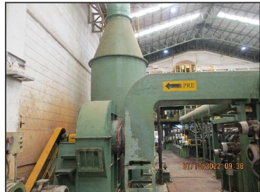
ภาพที่ 2.2 ปล่องระบายอากาศของระบบดักจับไอสารเคมี (Wet Scrubber)
