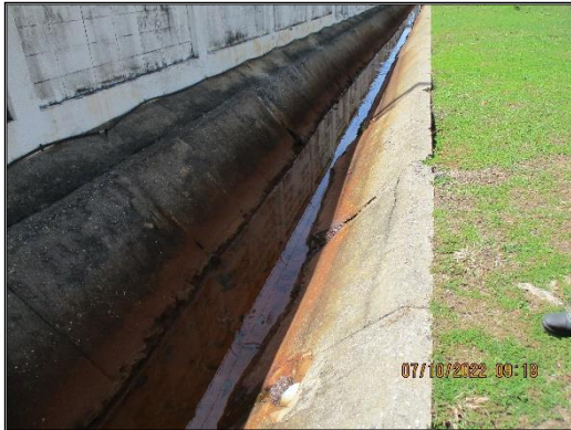
ภาพที่ 2.14 รังระบายน้ำฝนในพื้นที่โครงการฯ
