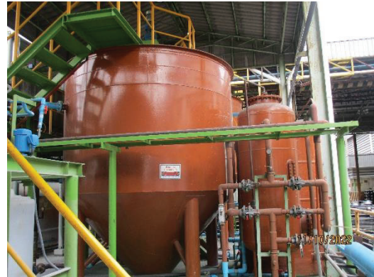
ภาพที่ 2-10 ระบบบำบัดน้ำเสียทางเคมี
