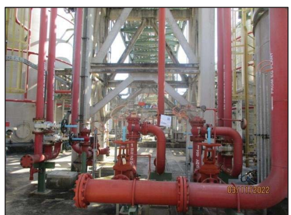
รูปที่ 3.41 Hydrant with Monitor
