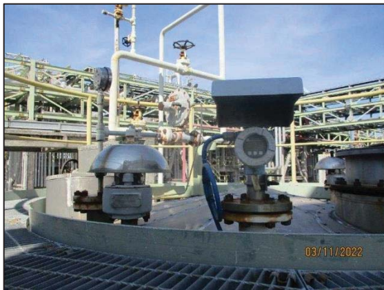
รูปที่ 3.47 Pressure Safety Valve
