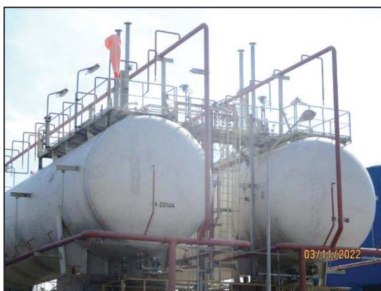
รูปที่ 3.45 ระบบสเปรย์น้ำแอมโมเนีย
