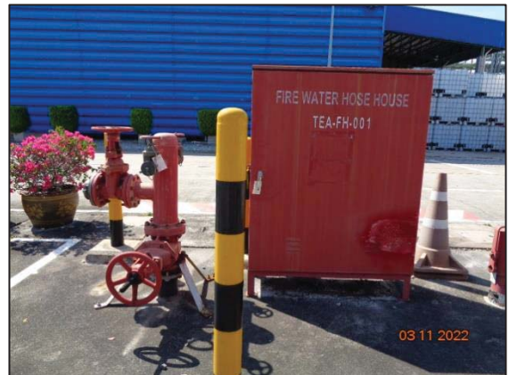
รูปที่ 3.44 Fire Water Hose House
