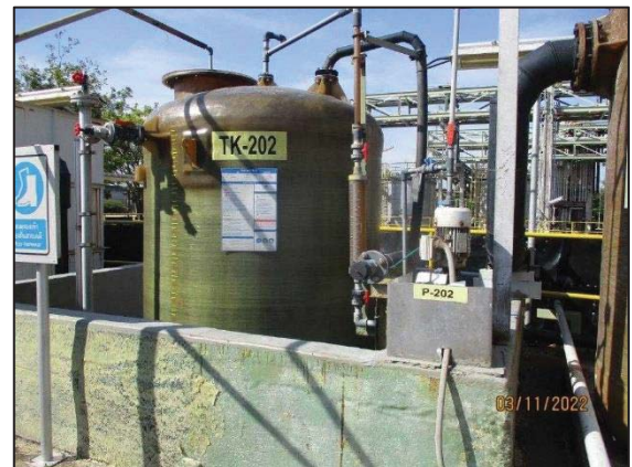
รูปที่ 3.18 ปั๊มที่ใช้กับระบบบำบัดน้ำเสีย
