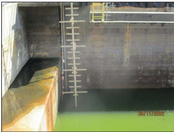
รูปที่ 3.3 บ่อ Neutralization (TK 201)
