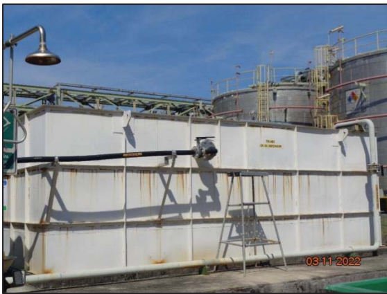
รูปที่ 3.15 Oil-water Separator (CPI)
