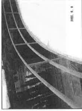
รูปที่ 15. Roof Handrail พบผิวสีชมพูสภาพพบผิวดินเรียบ ส่วนใหญ่อยู่ในสภาพดี
