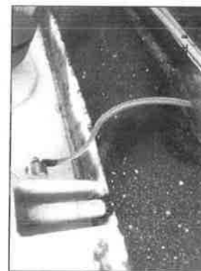
รูปที่ 5. Anchor Chain Anchor Bolt พบสันนูนเล็กน้อย ส่วนนี้อยู่ในสภาพดี
