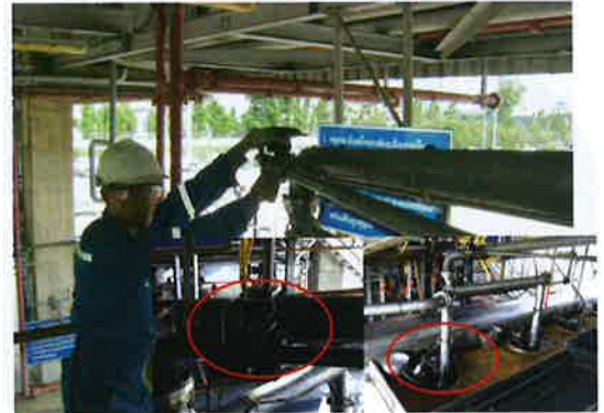
นำวงจรจ่ายไฟ 4 วงจรมาเก็บกัน ล็อควงจรทุกครั้ง
