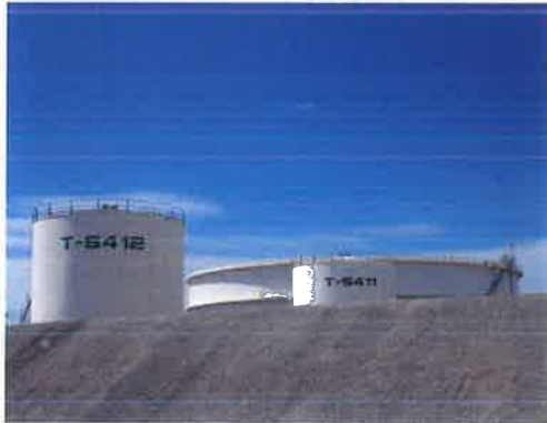
รูปที่ 3-15 ถังเก็บน้ำเสียจากกันถังคอนเดนเสท (ถัง T-5411 และถัง T-5412)
