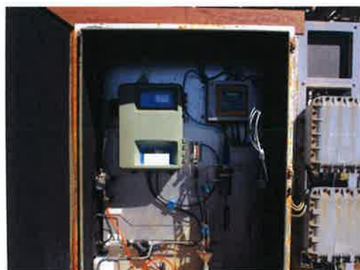
รูปที่ 3-55 Conductivity Meter และ pH Online ที่บริเวณจุดระบายน้ำ Blowdown
