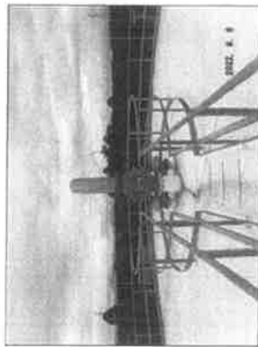
รูปที่ 17. Walk way พบสนิมเล็กน้อยและสนิมเล็กน้อย ส่วนใหญ่อยู่ในสภาพดี
