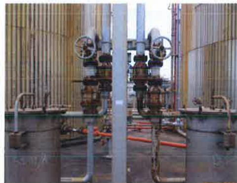
รูปที่ 3-7 Activated Carbon Canister
