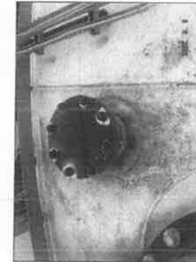
รูปที่ 27. Rod Nozzle พบสนิมเล็กน้อยและสนิมเล็กน้อยและสนิมเล็กน้อย ส่วนใหญ่อยู่ในสภาพดี
