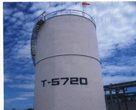
รูปที่ 3-14 Ballast Tank (T-5720) รวบรวม น้ำเสียปนเปื้อนน้ำมันจากเรือ
