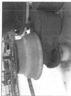
รูปที่ 19. Vent with Densitator พบสนิมเล็กน้อยและสนิมเล็กน้อยและสนิมเล็กน้อย ส่วนใหญ่อยู่ในสภาพดี
