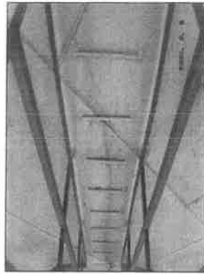
รูปที่ 17. Walk way พบสนิมเล็กน้อยและสนิมเล็กน้อย ส่วนใหญ่อยู่ในสภาพดี
