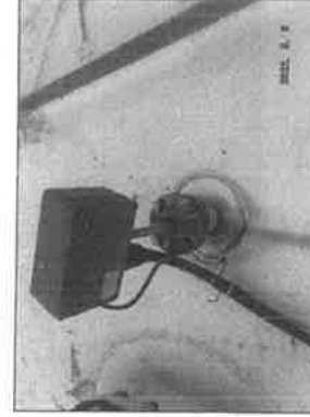
รูปที่ 25. Rod Nozzle พบสนิมเล็กน้อยและสนิมเล็กน้อยและสนิมเล็กน้อย ส่วนใหญ่อยู่ในสภาพดี
