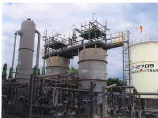
รูปที่ 3-8 Vapor Recovery Unit (VRU)
