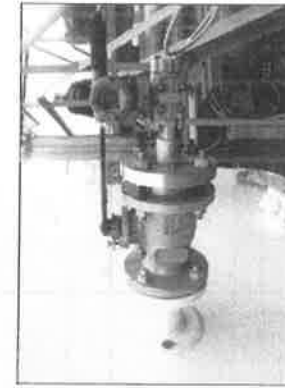
รูปที่ 9. Shell Nozzle พบสันนูนเล็กน้อยบริเวณหัวปลอก Bolt พบ ส่วนนี้อยู่ในสภาพดี
