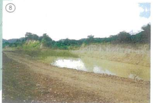
ทำคันดินปิดกั้นขุมเหมืองเก่า ไซ้เป็นยอด้กตะกอน
