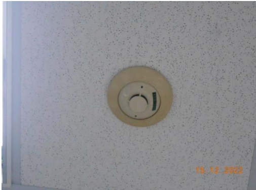
รูปที่ 53 Smoke Detector
