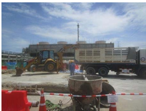
รูปที่ 5 การกั้นขอบเขตพื้นที่ก่อสร้าง
