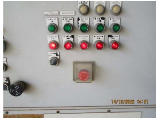
รูปที่ 72 ระบบ Emergency Shutdown System
