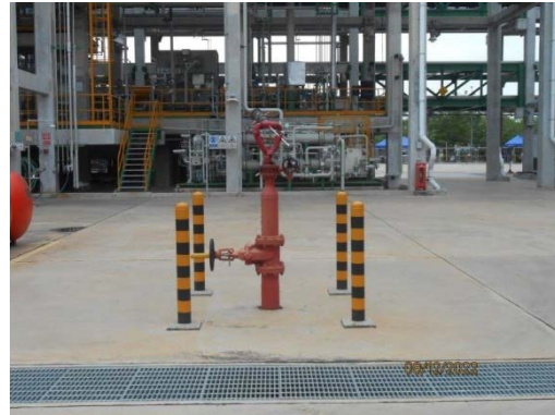
รูปที่ 48 หัวฉีดน้ำดับเพลิง
