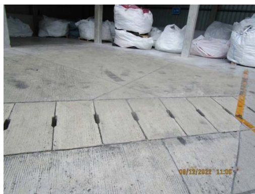
รูปที่ 22 รางระบายน้ำที่มีตะแกรงปิดสำหรับรองรับ น้ำที่ใช้ทำความสะอาดพื้นที่อาคารเก็บวัสดุ
