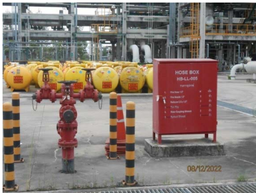
รูปที่ 49 Hydrant และ Hose box
