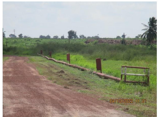
รูปที่ 10 (ต่อ) ระบบป้องกันอัคคีภัยรอบลานกองขานอ้อย
