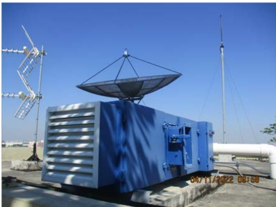
รูปที่ 2-13 ระบบบำบัด Aerosol
