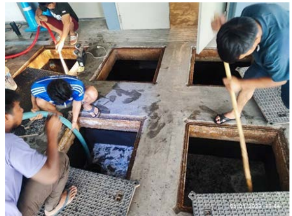
รูปที่ 2-11 การสูบลากตะกอน
