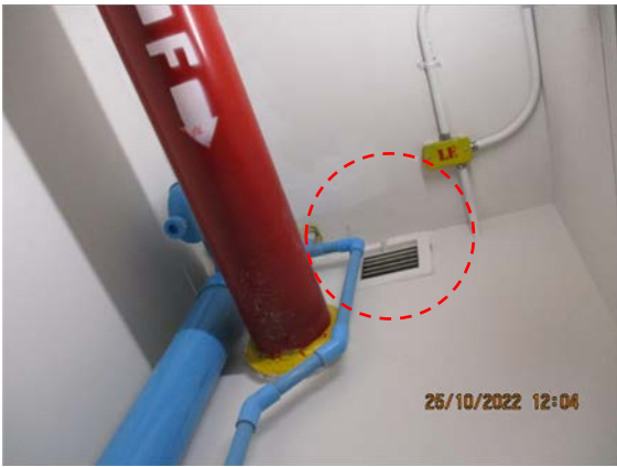
รูปที่ 2-16 ระบบระบายอากาศภายในห้องพักมูลฝอย
