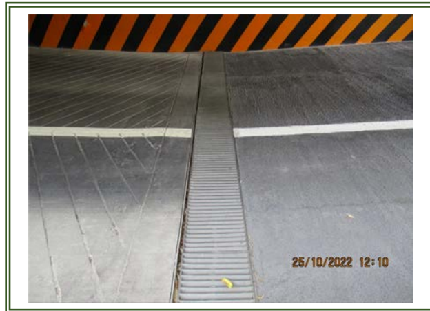
รูปที่ 2-58 ตะแกรงครอบท่อระบายน้ำ
