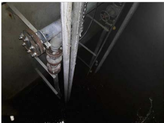
รูปที่ 2-31 เครื่องสูบน้ำในบ่อหน้า
