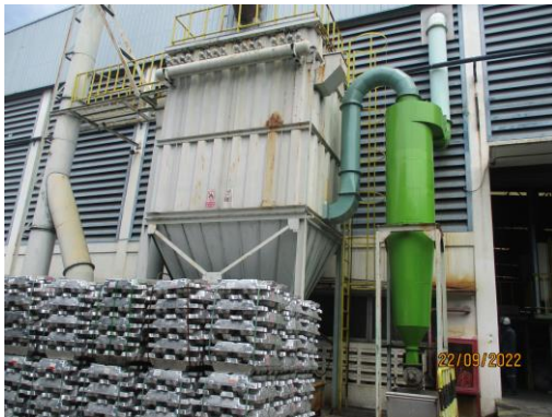
รูปที่ 2 ระบบดักฝุ่นแบบไซโคลน
