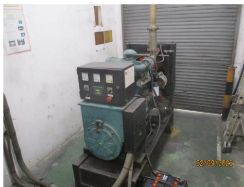
รูปที่ 12 ระบบไฟฟ้าสำรองชนิดใช้น้ำมันดีเซล
