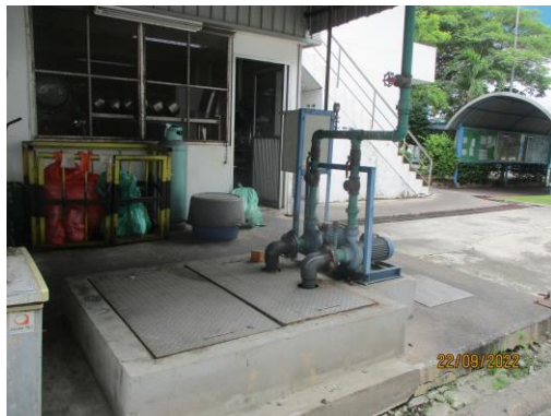
รูปที่ 16 ถังบำบัดน้ำเสียสำเร็จรูปและถังตกไขมัน
