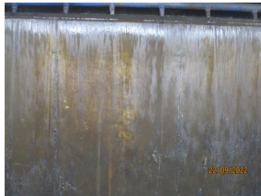
รูปที่ 8 ระบบม่านน้ำของกระบวนการพ่นสี
