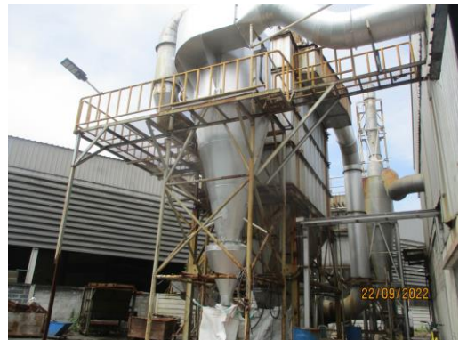
รูปที่ 2 ระบบดักฝุ่นแบบไซโคลน
