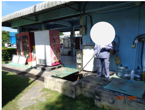
จุดปล่อยน้ำทิ้งของโรงงานก่อนออกสู่ท่อรวบรวมน้ำเสียของนิคมฯ (Inspection Tank)
