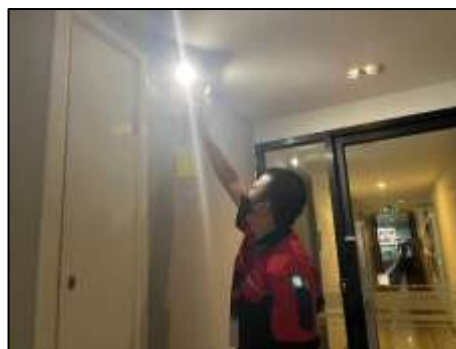
รูปภาพที่ 12 ตรวจเช็คไฟฉุกเฉินประจำเดือน
