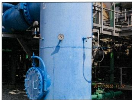
ภาพถ่ายที่ 2.2-12 เครื่องวัดอุณหภูมิของท่อหล่อเย็น
