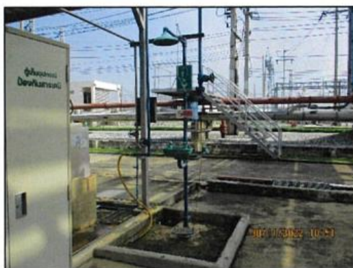
ภาพถ่ายที่ 2.2-26 อุปกรณ์ชำระล้างฉุกเฉิน (Emergency Shower and Eye Wash Fountain)
