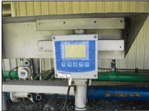
ภาพถ่ายที่ 2.2-14 เครื่องตรวจวัดค่า pH, Temp, Conduct แบบอัตโนมัติ
