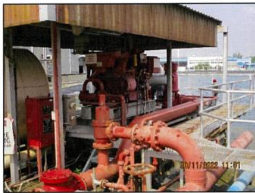
ภาพถ่ายที่ 2.2-36 บั๊มน้ำดับเพลิงของโครงการ
