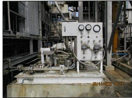
De-NO x Water System HRSG#2
