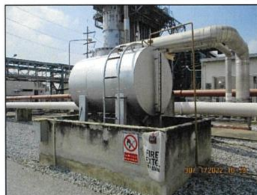
ภาพถ่ายที่ 2.2-33 เขื่อนคอนกรีต (Bund wall)
