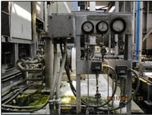
De-NO x Water System HRSG#1
