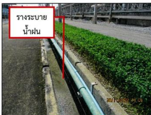
ภาพถ่ายที่ 2.2-18 รางระบายรวบรวมน้ำฝน ท่อระบายน้ำเสีย
