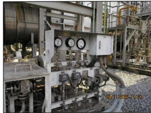
De-NO x Water System HRSG#4
