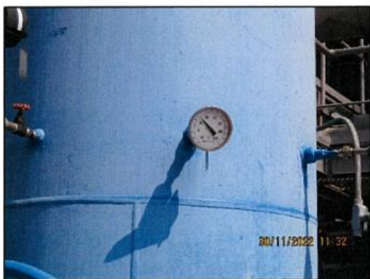
ภาพถ่ายที่ 2.2-12 เครื่องวัดอุณหภูมิของท่อหล่อเย็น
