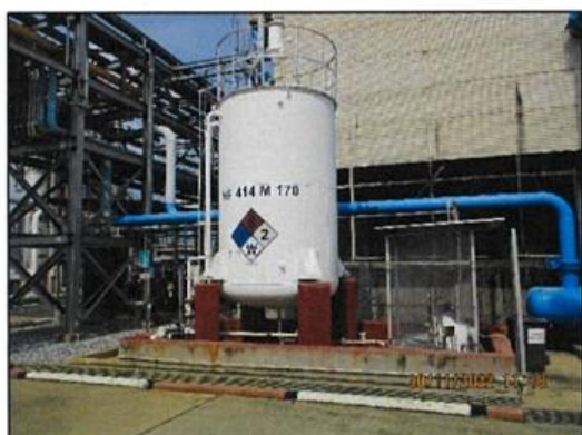
ภาพถ่ายที่ 2.2-33 เขื่อนคอนกรีต (Bund wall)
