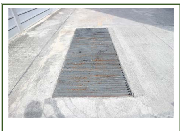
รูปที่ 2-46 ตะแกรงครอบตามรูท่อระบายน้ำ
