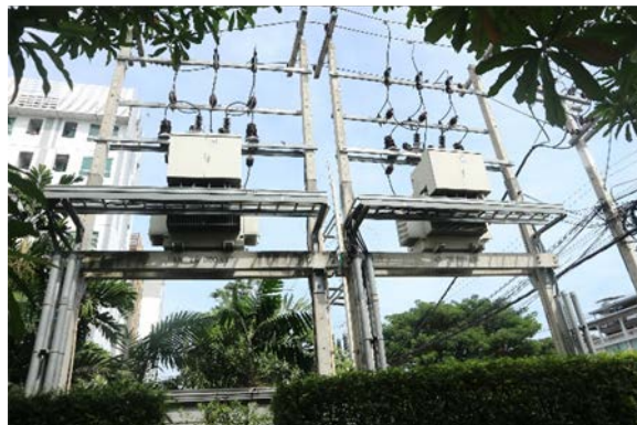
รูปที่ 2-28 หม้อแปลงไฟฟ้า
