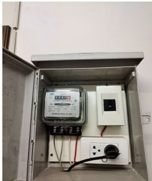
รูปภาพที่ 14 ภาพมิเตอร์ไฟฟ้าระบบ บำบัดน้ำเสีย
