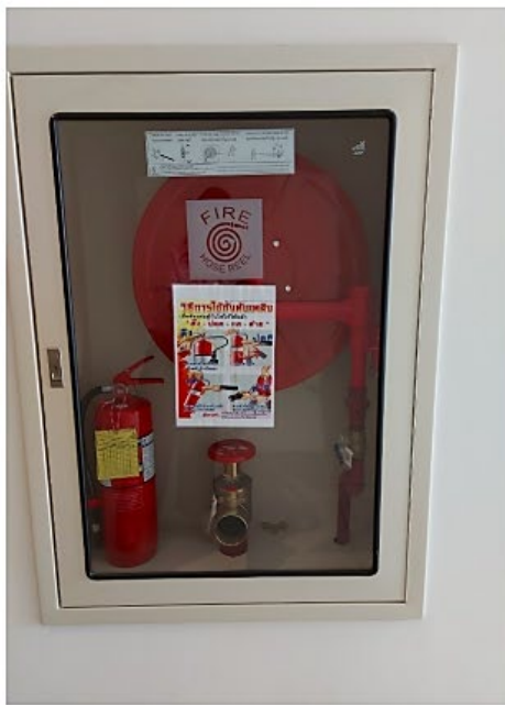
รูปภาพที่ 94 ภาพตู้เก็บสายฉีดน้ำดับเพลิง พร้อมอุปกรณ์ (Fire Hose Cabinet: FHC)
