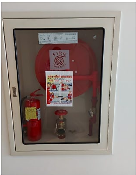
รูปภาพที่ 95 ถังดับเพลิงแบบมือถือ ขนาด 10 ปอนด์ในตู้ FHC
