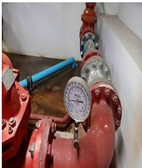
รูปภาพที่ 91 ภาพท่อเย็น (Stand Pipe)
