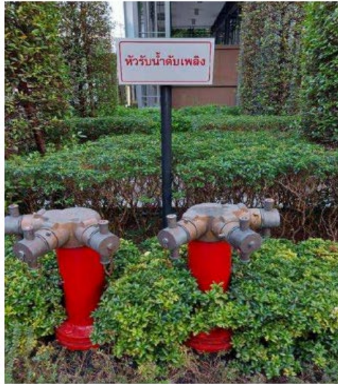
รูปภาพที่ 13 ภาพหัวรับน้ำดับเพลิง ด้านหน้าโครงการ
