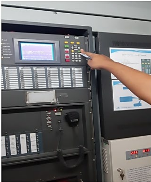
รูปภาพที่ 101 ภาพแผงควบคุมระบบเตือน อัคคีภัย
