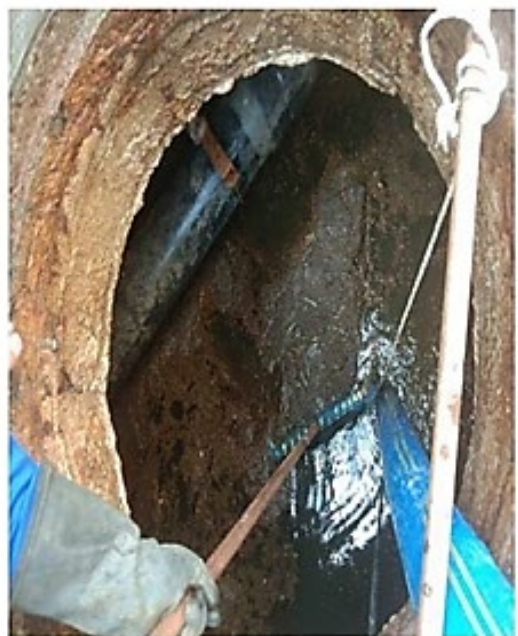
รูปภาพที่ 12 การสูบน้ำบ่อเกรอะ
