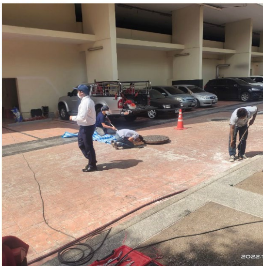
รูปภาพที่ 46 ตรวจสอบดูแลบ่อพักของ ระบบระบายน้ำ
