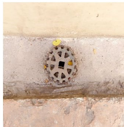
รูปภาพที่ 145 ภาพตระแกรงครอบตามท่อ ระบายน้ำ
