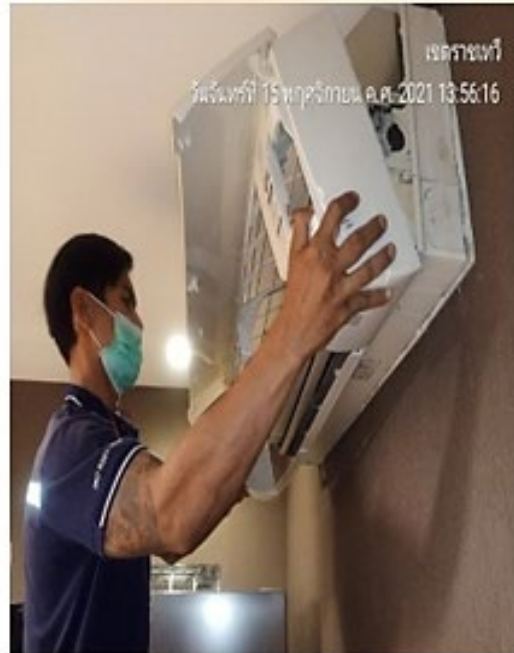
รูปภาพที่ 134 ภาพการทำความสะอาดเครื่องปรับอากาศ
