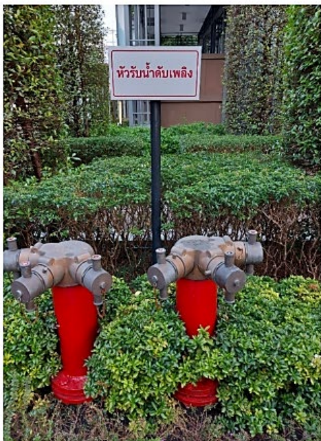
รูปภาพที่ 93 ภาพหัวรับน้ำดับเพลิงนอก อาคาร
